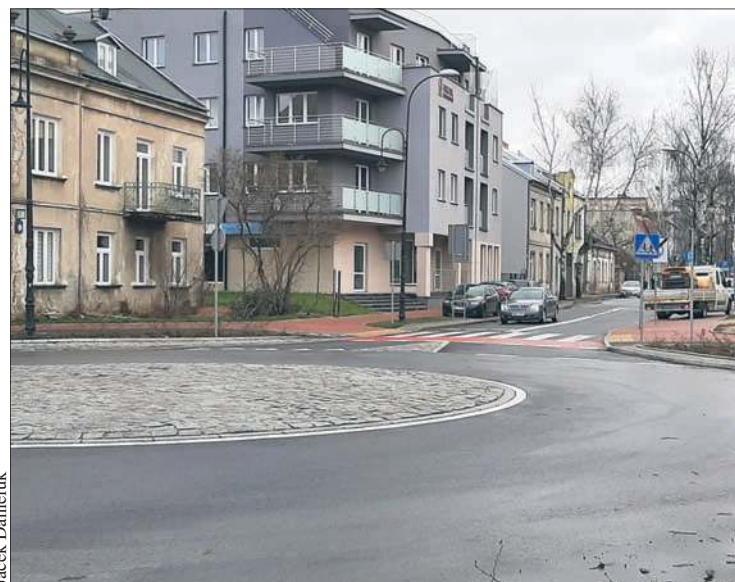
Prace na ul. 3 Maja będą prowadzone od ronda na skrzyżowaniu z łącznikiem do al. Jachowicza do skrzyżowania z al. Kilińskiego
