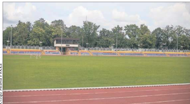
Stadion miejski im. Bernarda Szymańskiego zostanie przebudowany. Prace zakończą się w przyszłym roku
