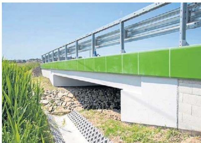
Most to solidna konstrukcja żelbetowa o długości ponad 12 m i szerokości 9 m
