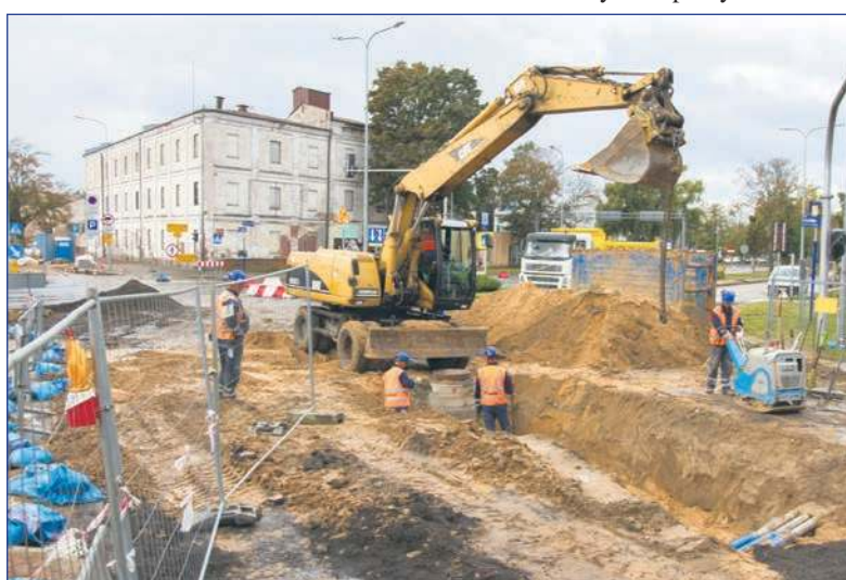
Trwa rozbudowa sieci kanalizacji w centrum miasta
