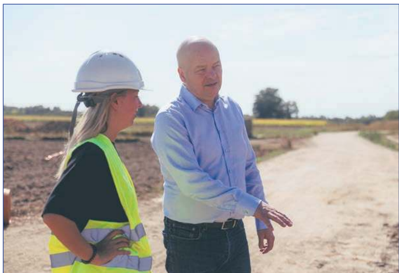
Prezydent Płocka Andrzej Nowakowski na budowie nowego odcinka ul. Przemysłowej
