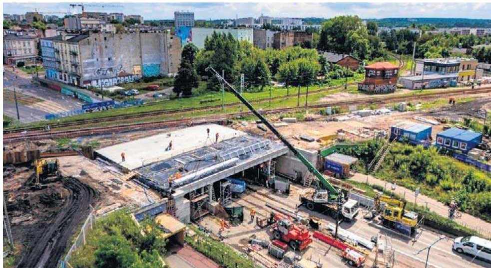
15 listopada zostanie znów zamknięty przejazd pod przebudowywanym wiaduktem nad ul. Piłsudskiego w centrum Sosnowca
