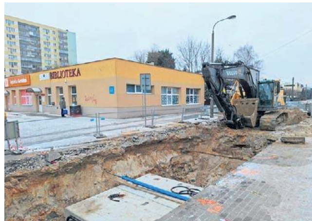
Pod koniec stycznia prace ruszyły na ul. Koszalińskiej
