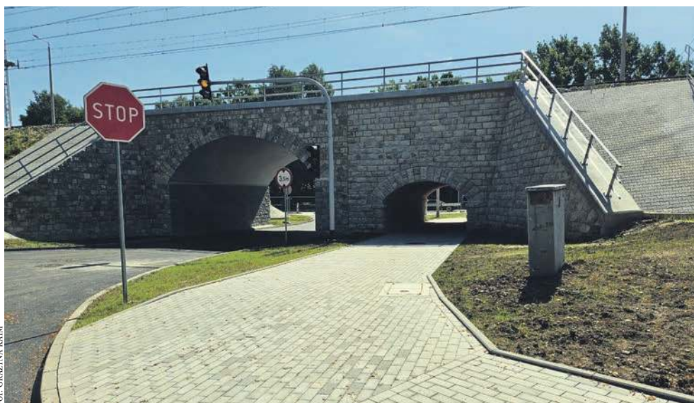
Wiadukt na ul. Siennej w Chrzanowie
