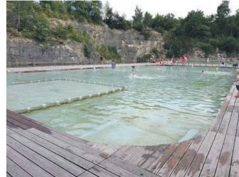
W brodziku dla dzieci już widać osad na płytach
