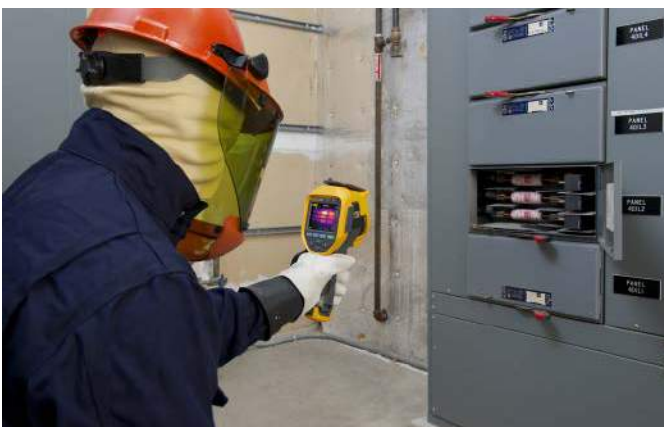
Fotografia 5. Pracownik diagnozujący złącza elektryczne w szafie sterowniczej z pomocą kamery Fluke Ti480
