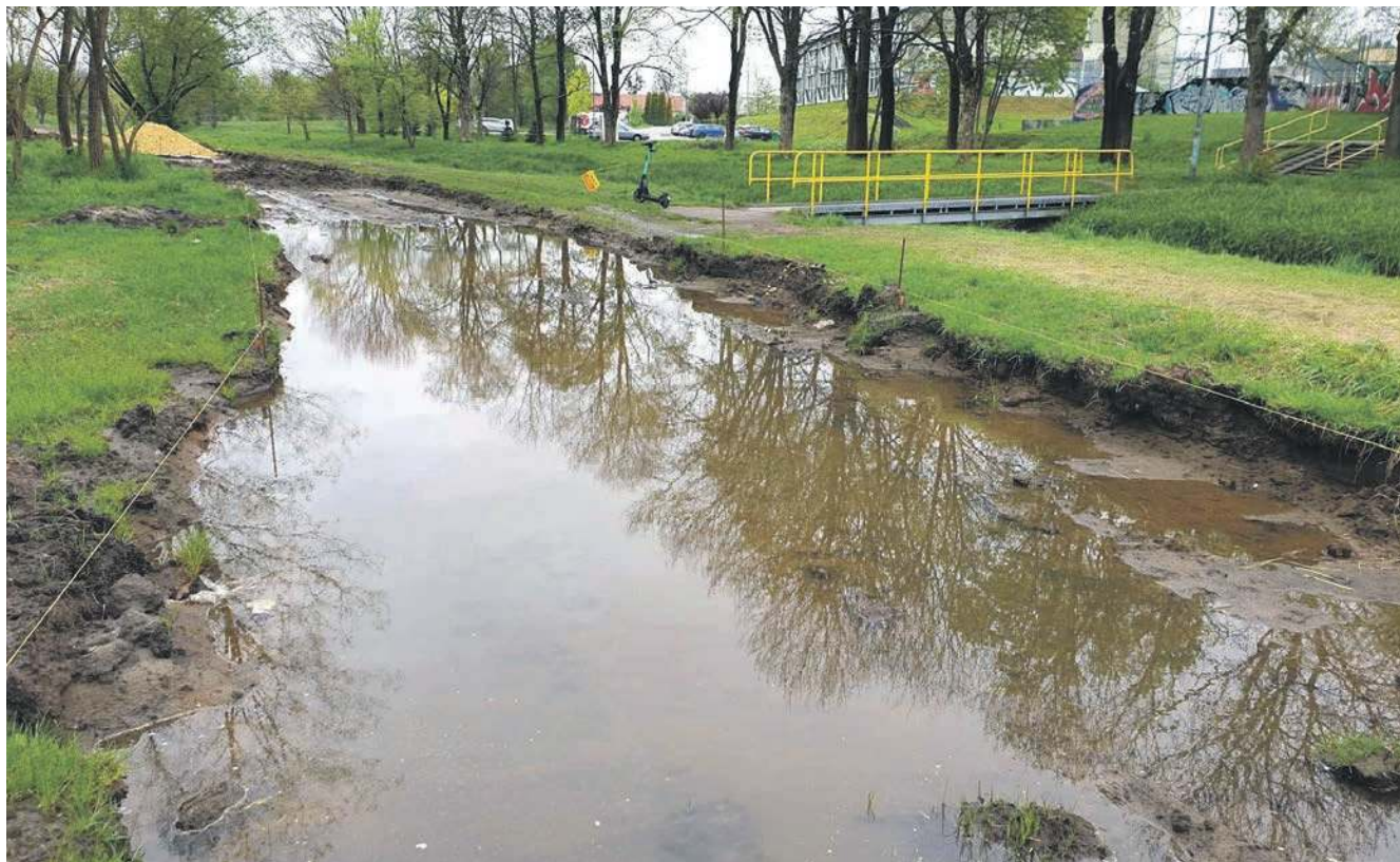
Tak wygląda zalany teren Kierkowa, gdzie powstaje ścieżka rowerowa. Żółte nitki z prawej i lewej strony ścieżki wyznaczają jej szerokość
