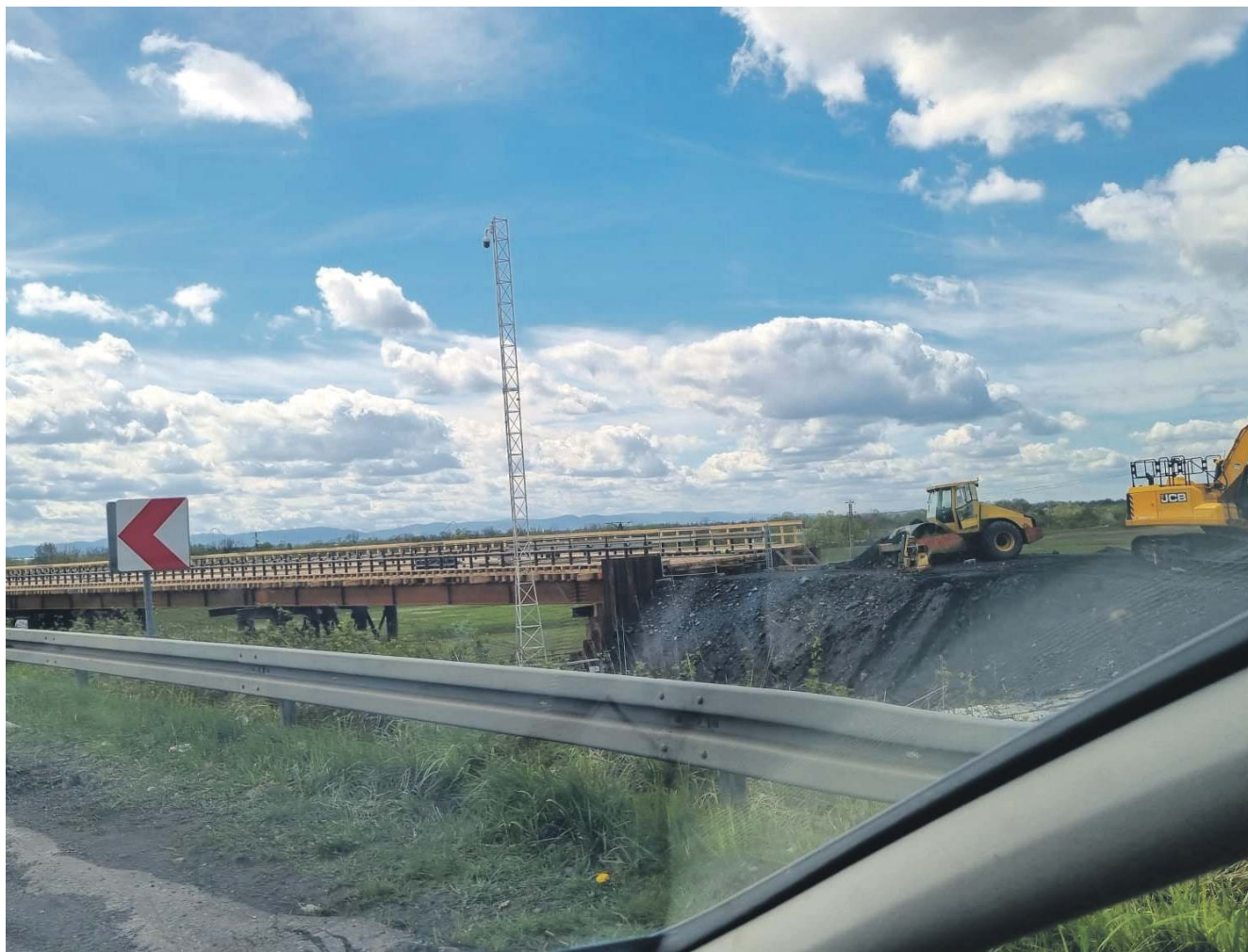
Trwa budowa mostu tymczasowego na Wiśle w Jankowicach
