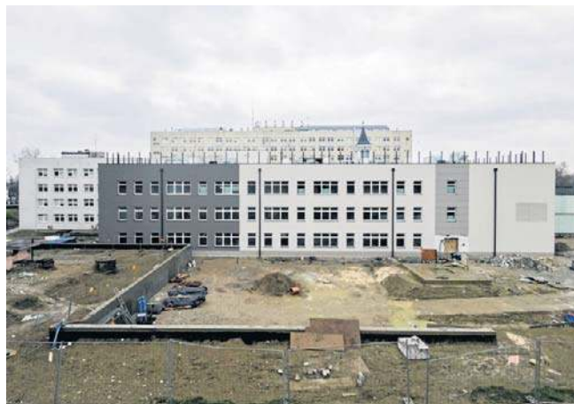
Budowa nowego bloku operacyjnego rozpoczęła się w połowie zeszłego roku, termin wykonania mija za trzy miesiące
