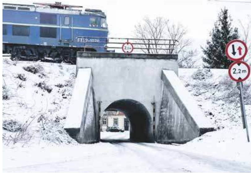
Po remoncie wiadukt będzie prezentował się o wiele lepiej, niż obecnie
