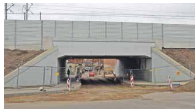
Przejazd pod wiaduktem zostanie zamknięty w czwartek
