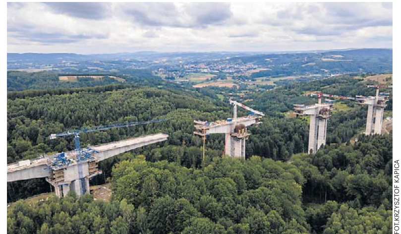
Estakada ES-26 pomiędzy miejscowościami Żarnowa i Godowa
