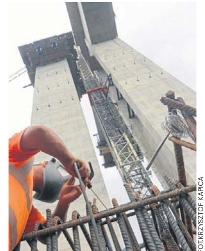
Trwają zaawansowane prace przy budowie S19
