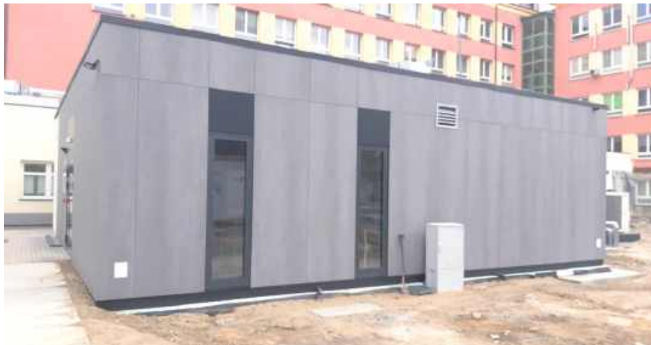
5 mln zł kosztowała cała pracownia rezonansu, włącznie z głównym urządzeniem
