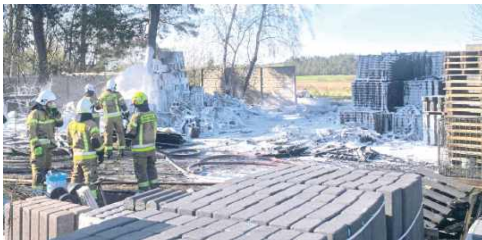
Strażacy podawali wodę i pianę gaśniczą, ograniczając rozprzestrzenianie się pożaru na pozostałą część składu oraz pobliski teren zadrzewiony
