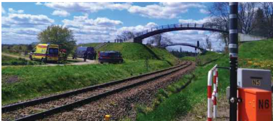
Jak poinformowała podkomisarz Dorota Krukowska-Bubiło, działania te mają charakter standardowej procedury stosowanej w przypadku ujawnienia tego typu nieprawidłowości lub niejednoznacznych elementów w obrębie infrastruktury kolejowej
