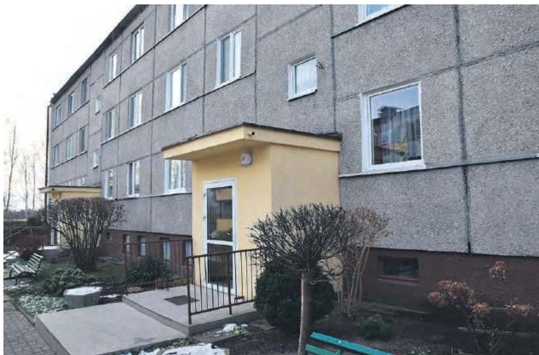
Mieszkańcy bloków przy ul. Słonecznej 5 i 6 w Gostycynie czekają na dostawę pomp ciepła.
