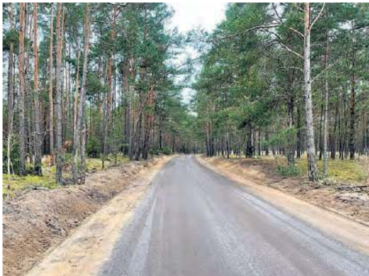
Droga została utwardzona kruszywem.
