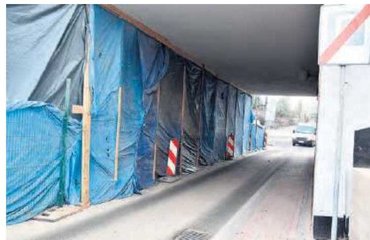
Pod wiaduktem mogą przejechać nadjeżdżający z kierunku Sępólna czy Czarnej Drogi.
