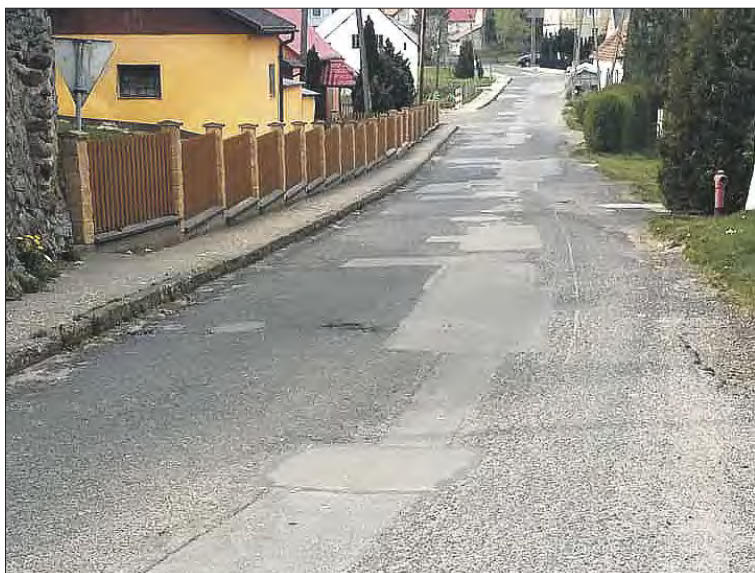
Ta droga w Gryżowie zostanie zmodernizowana
