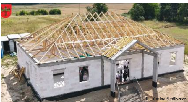
Budowa obiektu przebiega bardzo sprawnie
