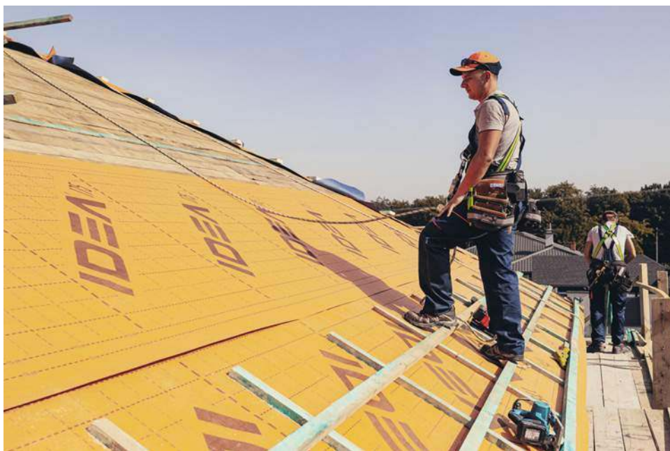
❷ Uwaga praktyczna – FWK układa się napisami do góry. MARMA POLSKIE FOLIE
