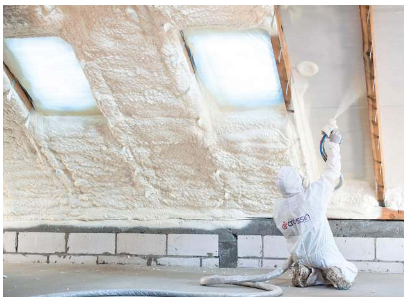
Ocieplenie dachu pianą poliuretanową PUR nanoszoną natryskowo. PCC PRODEX
