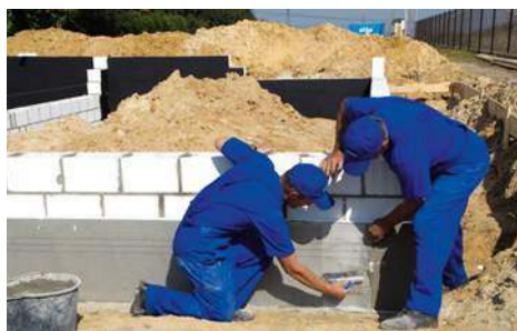
❸ Największe zalety silikatów to bardzo duża wytrzymałość, dobra izolacyjność akustyczna i wysoka akumulacyjność. SILKA (XELLA)
