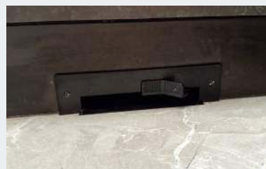
● Automatyczną szufelkę zamontowano w cokole szafki kuchennej.
