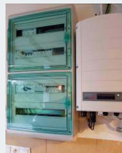
● Licznik i falownik ułożono w garażu.
