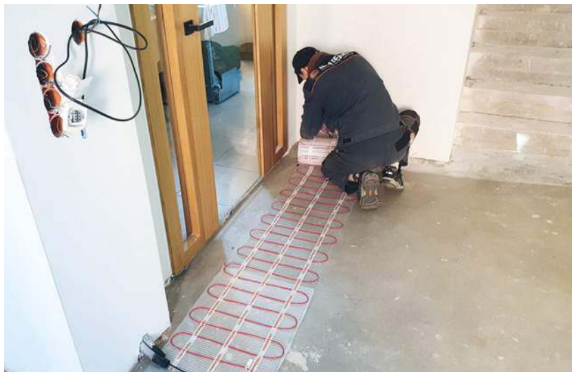
ⓘ Układanie maty grzewczej. THERMOVAL
