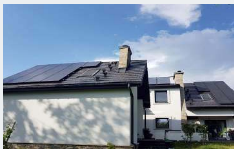
● Płaskie kolektory zamocowano na środkowym dachu, panele PV na częściach zewnętrznych.
