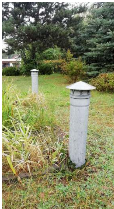
🔗 Na końcu rur drenarskich montuje się kominki napowietrzające. L. JAMPOLSKA
