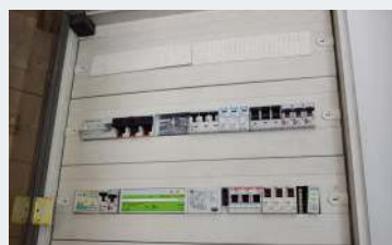
☛ W rozdzielnicy znajduje się inteligentny licznik (na górze po lewej). eprasa.pl b795812472
