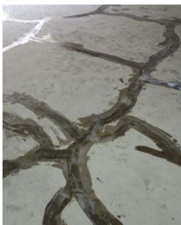
🔧 Zastosowanie zestawu do naprawy pęknięć i zabezpieczania powierzchni posadzki w garażu. SCHOMBURG
