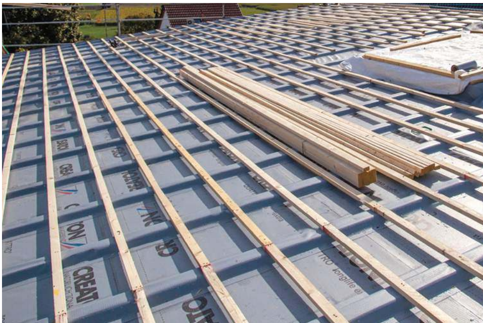
🔴 Podkład z membraną termozgrzewalną gotowy do układania dachówki. CREATON POLSKA
