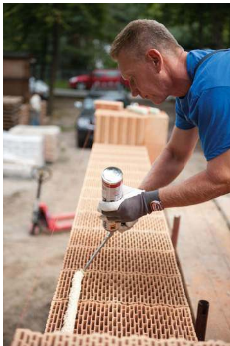
❷ Elementy z ceramiki poryzowanej mają około cztery razy lepsze parametry cieplne od tradycyjnej ceramiki. Są też lżejsze, co przyspiesza prace budowlane. WIENERBERGER
