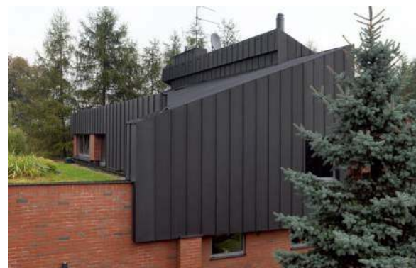
📌 Blacha płaska często mocowana jest do ścian na rąbek stojący. L. JAMPOLSKA
