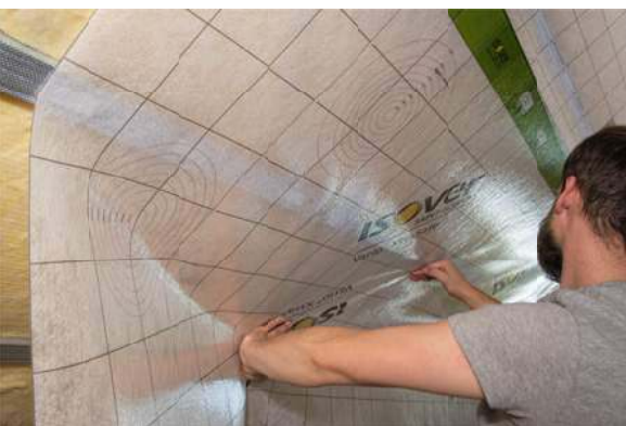
🔴 Folia paroizolacyjna układana na ociepleniu połaci dachu. ISOVER
