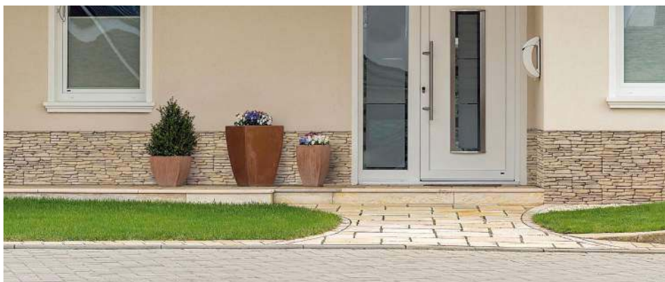
📍 Cokoły wykańcza się np. okładziną betonową. SEMMELROCK
