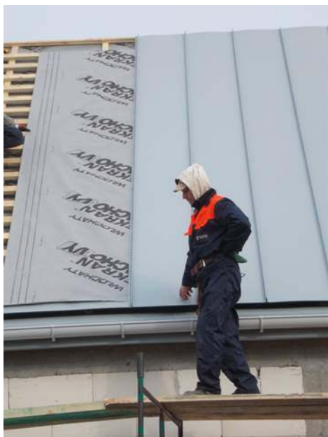
❶ Specjalna folia wstępnego krycia przeznaczona pod pokrycia z blachy na rąbek. MARMA POLSKIE FOLIE
