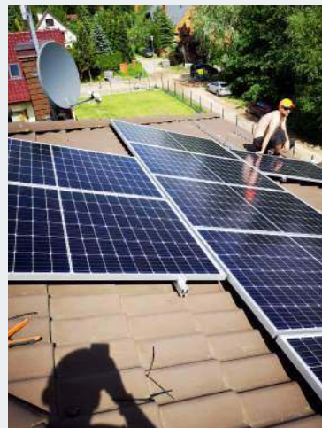
☛ Panele PV ułożono na południowo-wschodniej i południowo-zachodniej połaci o kącie nachylenia 28°.
