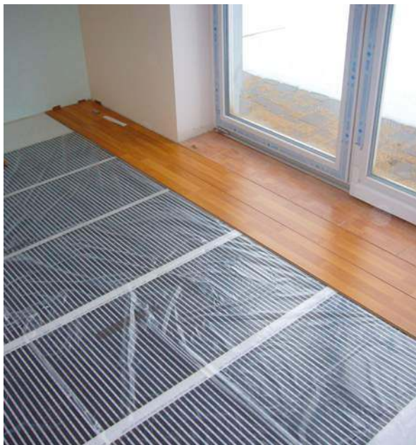
ⓘ Folię grzejną o grubości 0,4 mm można ułożyć bezpośrednio pod panelami. FENIX POLSKA
