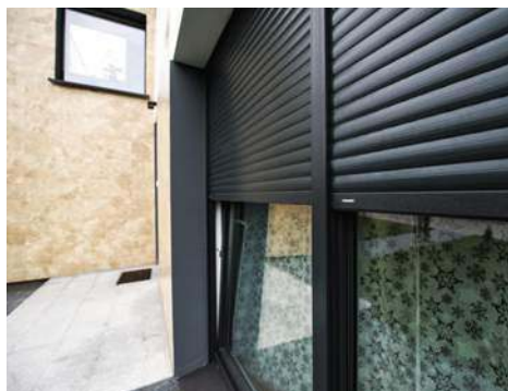
📍 Rolety zaplanowane na etapie projektu domu można zainstalować tak, by ich kasety były całkowicie niewidoczne. KRISPOL
