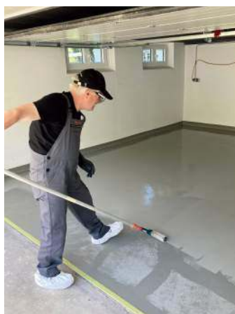
🔧 Zastosowanie zestawu do naprawy pęknięć i zabezpieczania powierzchni posadzki w garażu. SCHOMBURG
