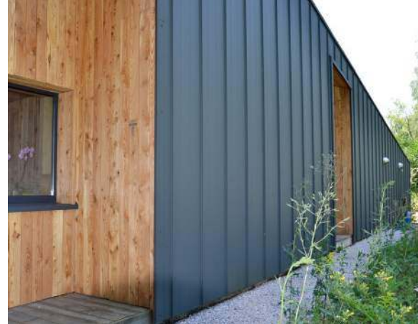
📌 Blacha płaska często mocowana jest do ścian na rąbek stojący. L. JAMPOLSKA
