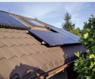
Kolektory próżniowe (2013 r.) i część paneli PV (2020 r.) zamontowano na południowej połaci dachu.
