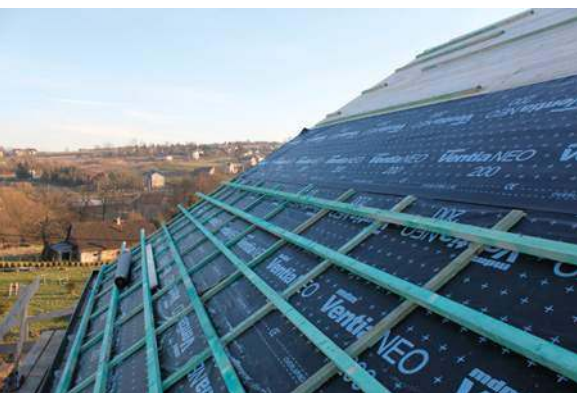
🔴 Folia wstępnego krycia pod rusztem z łąt i kontrłąt. MDM
