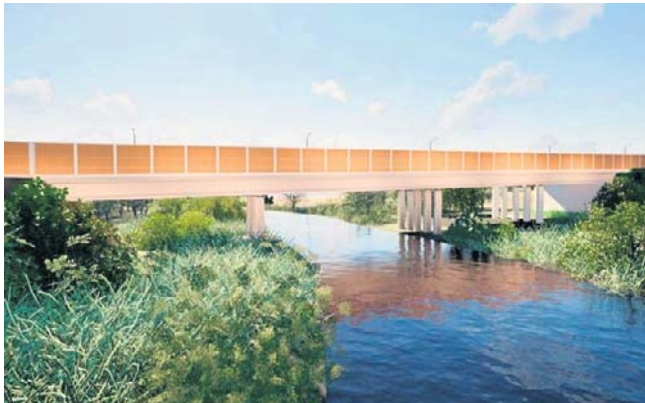
Wizualizacja nowego mostu przez Drwęcę w Nowej Wsi. Ta inwestycja wzbudza spore kontrowersje
