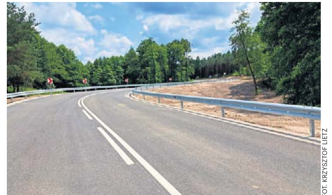
Pierwszy etap drogi do Wilczego Młyna łączący Sieradzką w Toruniu z Małgorzatowem jest od roku gotowy
