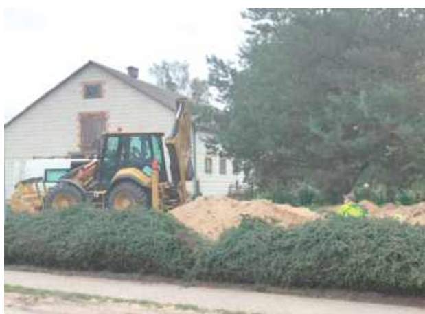
Wykonawcą zadania jest lokalna firma. 25 sierpnia została zawarta umowa pomiędzy Gminą Jabłoń a firmą PARSTER Sp. z o.o. z Parczewa, prace trwają
