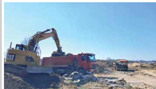
W ramach inwestycji wybudowane zostanie boisko o sztucznej nawierzchni o wymiarach 60 x 100 metrów
