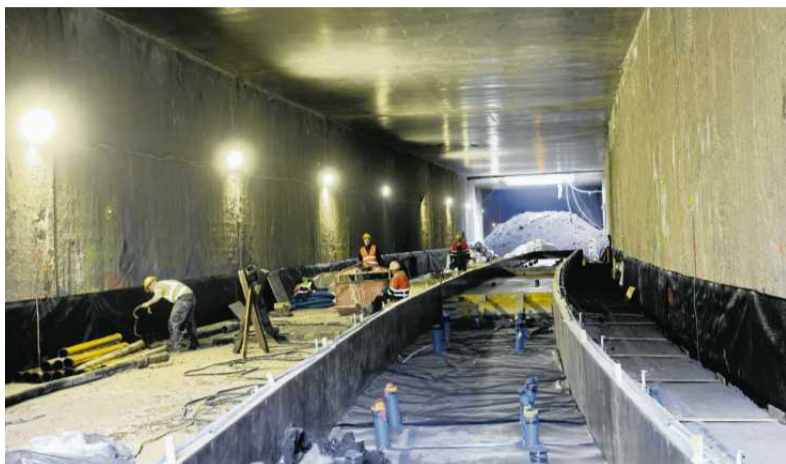
• Budowa tunelu dla tramwajów do Dworca Zachodniego
