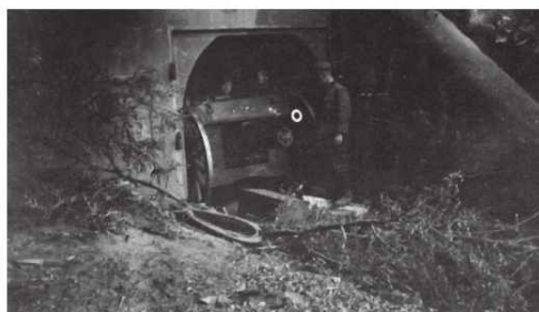
Armata tzw. prawosłonna będąca na wyposażeniu fortu III we wrześniu 1939 r. (forttrzcipomiechówek.org)
