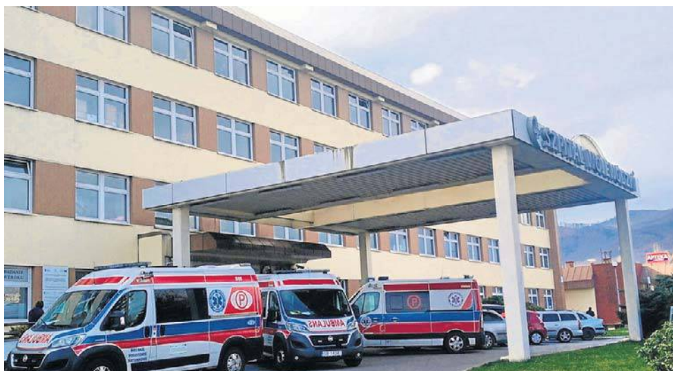
W czasie remontu dojście do budynku Szpitala Wojewódzkiego, z parkingu i przystanku autobusowego, będzie się odbywało pobliskim chodnikiem
