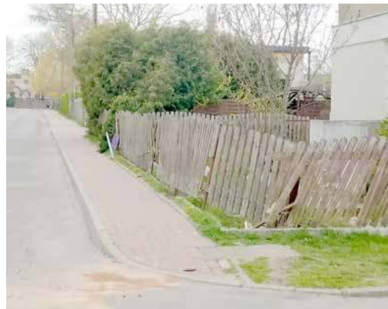
Zniszczone ogrodzenie i skasowane oznakowanie pionowe - tak wygląda miejsce po drogowej kolizji na Młynarskiej
