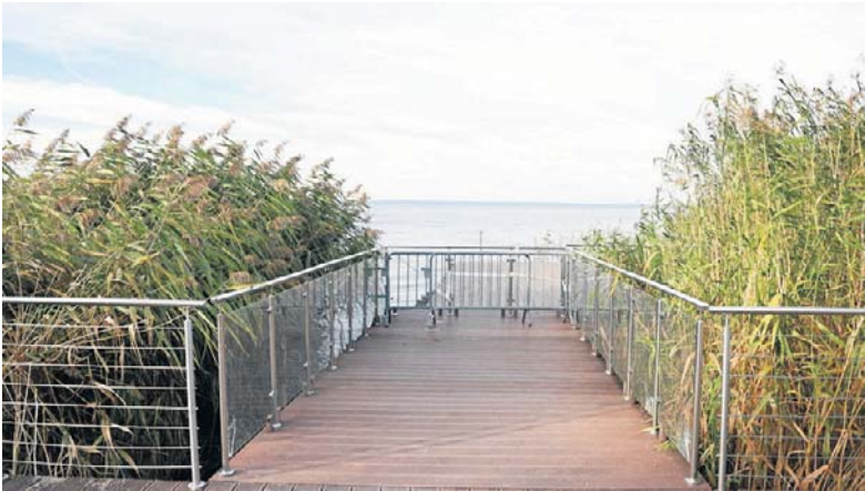
Wejście na pomost widokowy promenady jest obecnie zamknięte
