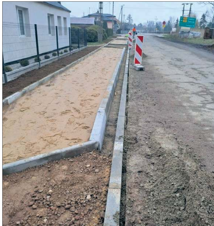
W marcu ruszyły prace związane z budową chodnika w ramach przebudowy odcinka drogi powiatowej nr 1443W Pacyna – Osmolin
