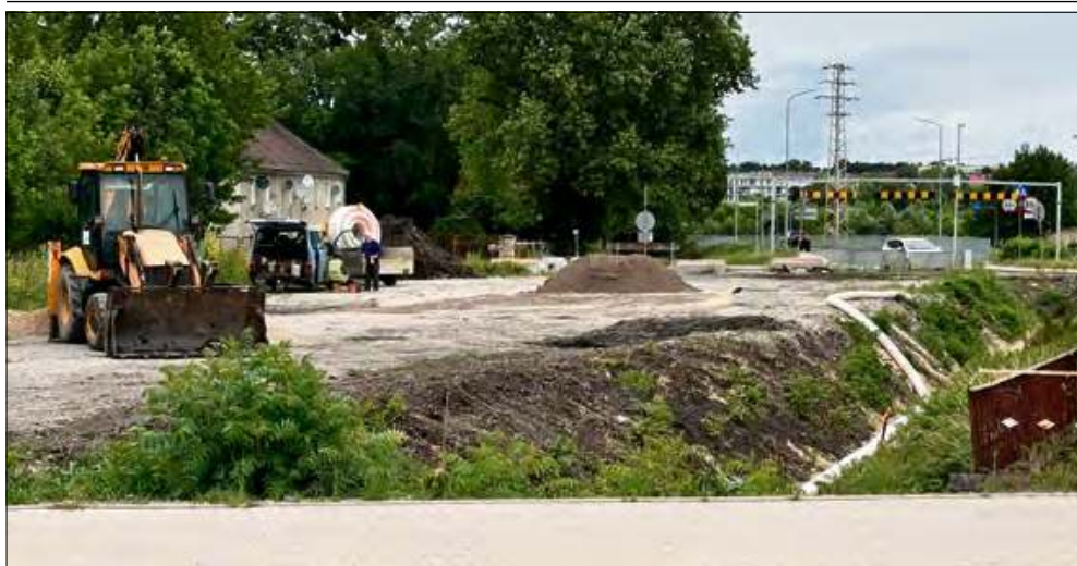
Powstanie łącznik drogowy pomiędzy zjazdem z Mostu Północnego a ulicą Opolską.
