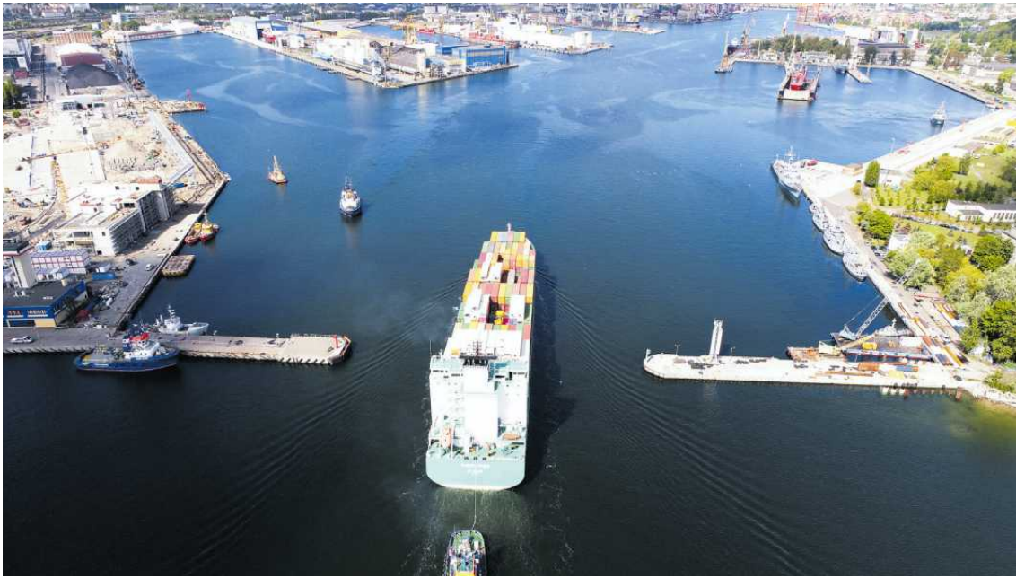
Poszerzone wejście wewnętrzne
