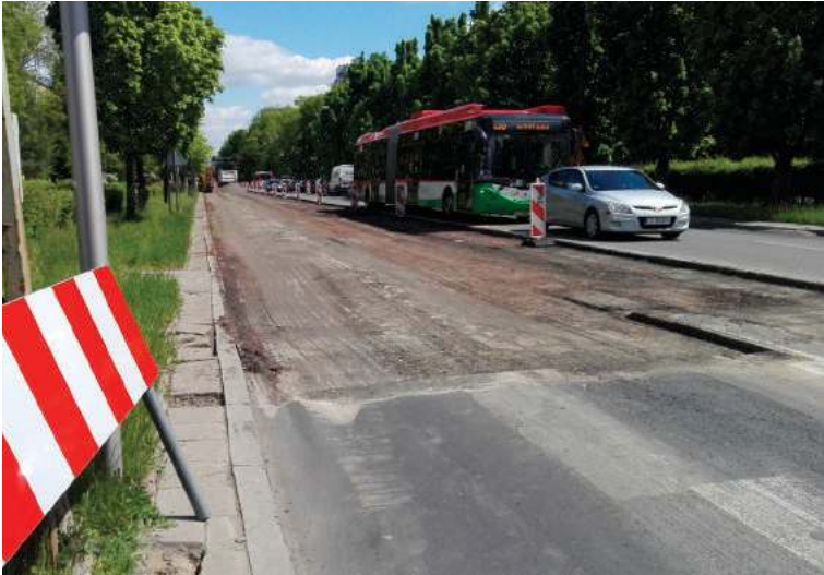
Ruch na Alejach Raclawickich odbywa się teraz jednym pasem. Z takimi utrudnieniami kierowcy muszą się liczyć przez najbliższy rok. Jeśli prace przebiegać będą zgodnie z planem, całość inwestycji ma być gotowa w czerwcu 2021 roku
