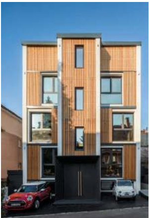
W kategorii: „Budynek po termomodernizacji” wygrał M3 project z Serbii, dom z 1969 roku całkowicie odnowiony w jeden nowoczesny obiekt
