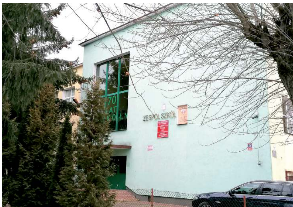
Procedura związana z likwidacją szkoły została zakończona 31 sierpnia ub.r. Dziś budynek stoi pusty i czeka na remont
