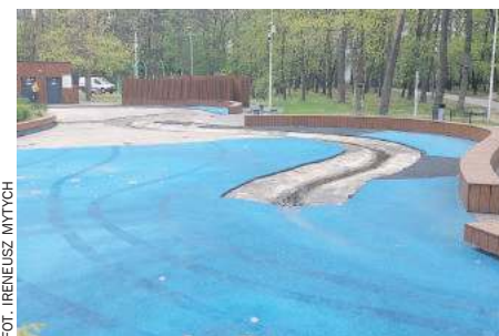
Po kilku latach intensywnej eksploatacji obiekt doczeka się remontu
