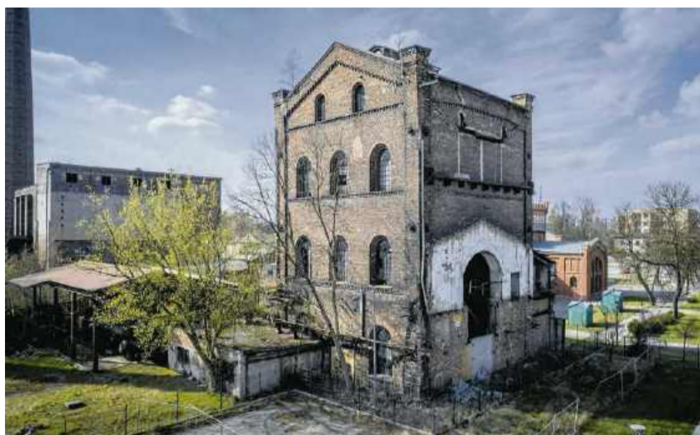
• Czeladź jest gotowa do rewitalizacji zabytkowej wieży szybowej nazywanej „basztową” i budynku maszyny wyciągowej byłej kopalni Saturn FOT. FB CHORZOWSKIEJ FIRMY EFEKT
