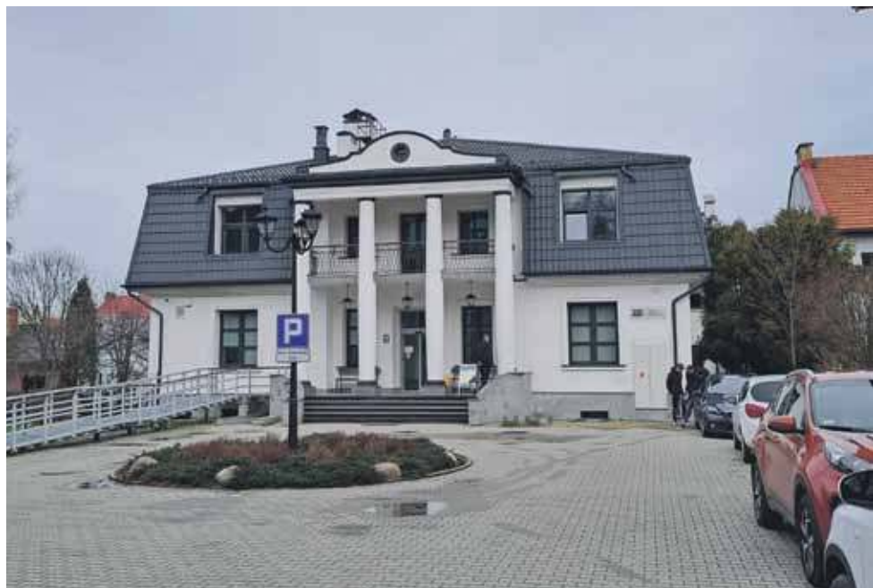
Wyremontowana siedziba nowotarskiego ZUS.
