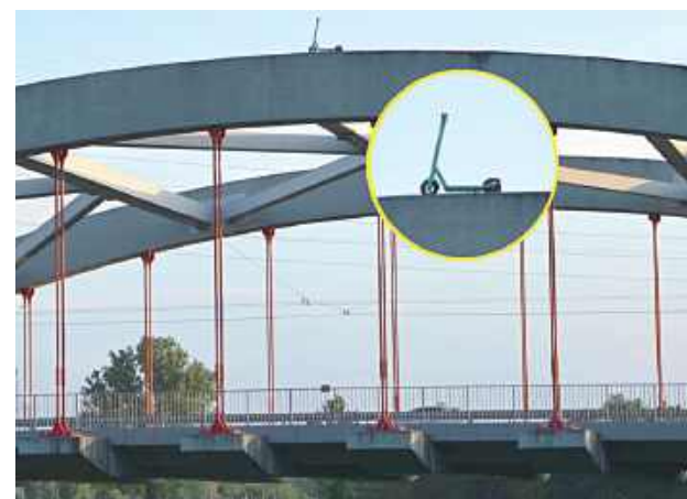
Użytkownik jednej z elektrycznych hulajnóg zaparkował ten pojazd na szczyście przęsła mostu 700-lecia Lublina na ul. Muzycznej. Kilkanaście metrów nad chodnikiem...
