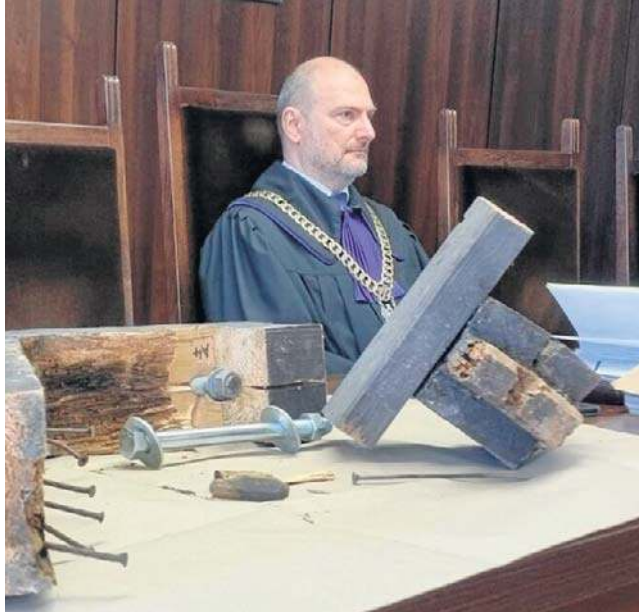
Śledczy ustalili, że zarówno na etapie projektowania, jak i wykonania ścieżki widokowej popełniono wiele uchybień.
