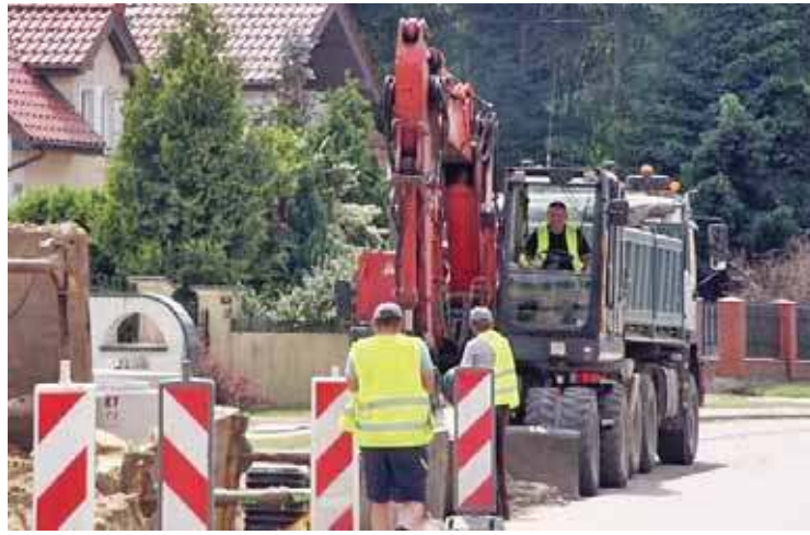
W ub. r. rozpoczęto budowę kanalizacji sanitarnej na ul. Batalionów Chłopskich
