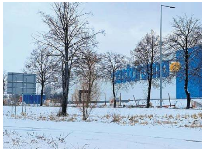
Budowa Castoramy w Zawierciu dobiega końca. M Park zostanie otwarty na wiosnę
