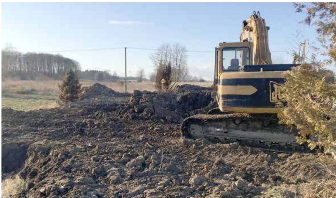
Prawidłowo wykonane prace ziemne są podstawą założenia dobrze funkcjonującego ogrodu
