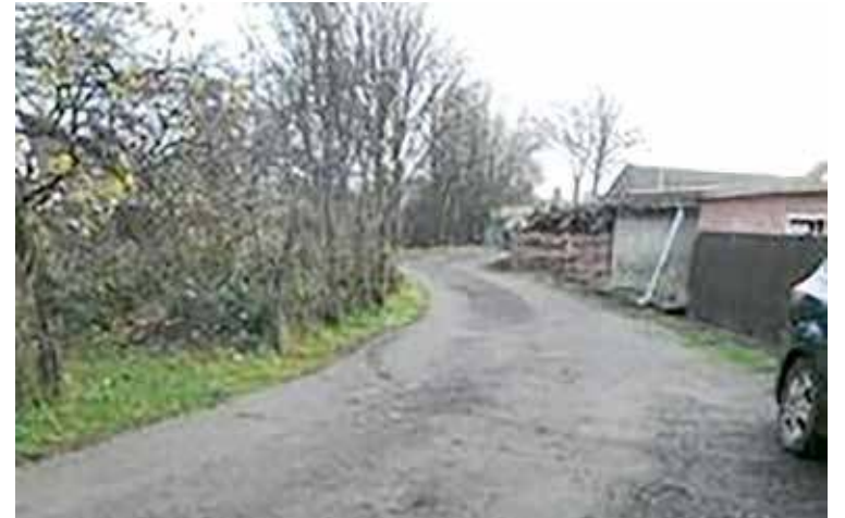
W Świerczewie w planach jest przebudowa odcinka drogi należącej obecnie do Skarbu Państwa
