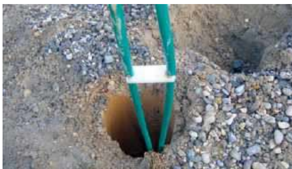
📍 Odwiert pod wymiennik pionowy. NIBE-BIAWAR
