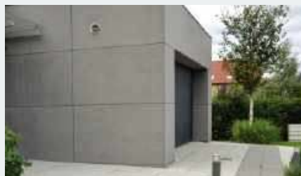
Czerpnię ulokowano w ścianie garażu, wurznię – po przeciwnej stronie.
