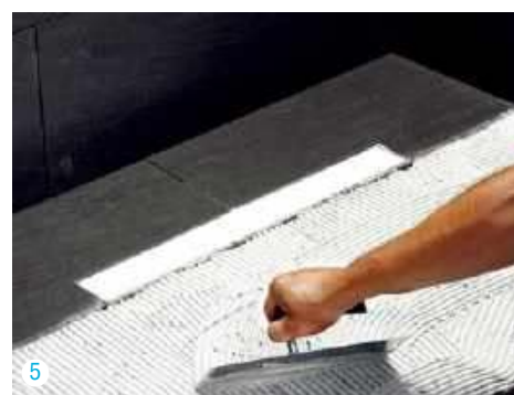
Kolejne etapy montażu odprowadzenia liniowego. TECE
