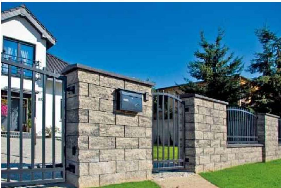
📌 Jeśli nie chcemy okalać posesji szczelnym murem, możemy np. wykonać podmurówkę i słupki z bloczków, a następnie zamocować do nich wybrane przęsła metalowe. JONIEC
