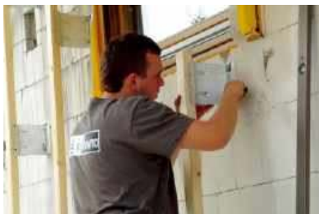
🔧 Montaż aluminiowej podkonstrukcji (do drewnianego rusztu) do ścian z betonu komórkowego. EKODREWNO
