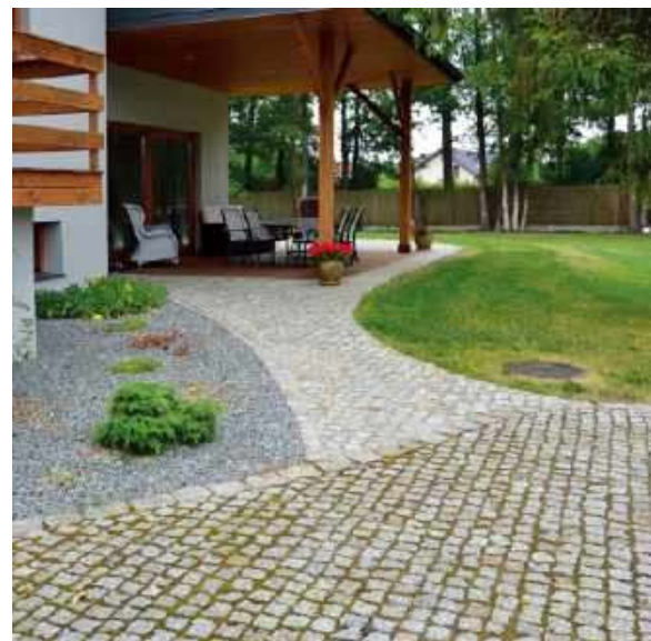
❹ Brak granitowy jest drogi, za jego ułożenie trzeba zapłacić 20% więcej, niż za betonowy. Poza tym, ze względu na powierzchnię kamienia, nie da się uzyskać idealnie równej nawierzchni. L. JAMPOLSKA
