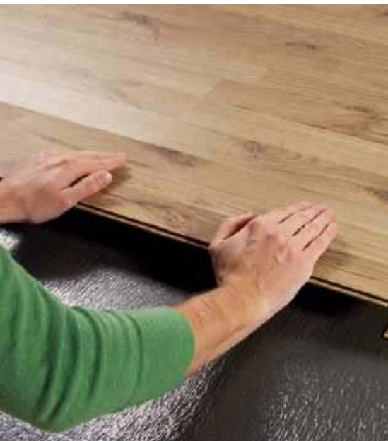
🔴 Pływającą posadzkę układa się nie bezpośrednio na stropie, a np. na rozłożonej na nim piance. HARO
