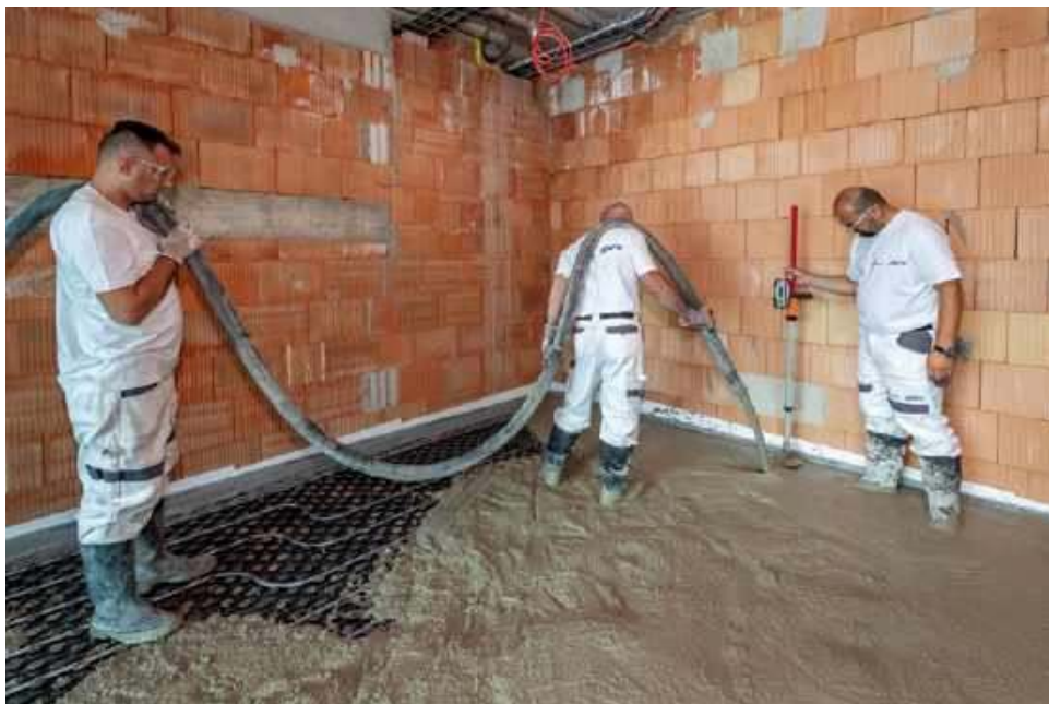
🔧 Jastrych anhydrytowy ma właściwości samopoziomujące, co bardzo ułatwia i przyspiesza prace. CEMEX
