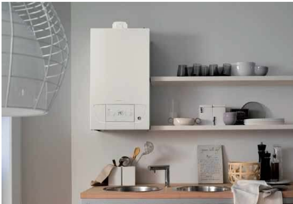
📍 Zamontowanie dwufunkcyjnego kotła, czyli podgrzewającego wodę przepływowo, pozwala zaoszczędzić sporo miejsca. DE DIETRICH
