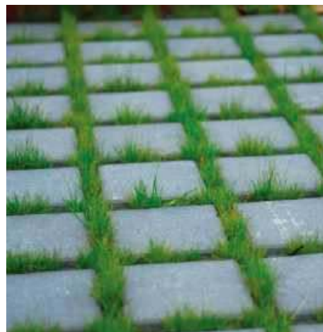
📍 Kostka brukowa płukana z warstwą kruszywa ułożona z odstępami. KAMAL
