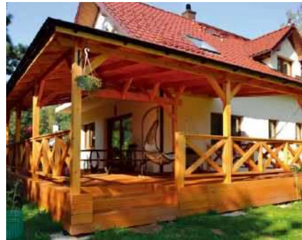
Pełne zadaszenie tarasu najczęściej pokrywa się takim samym materiałem, jak dach domu, np. lekką blachodachówką. L. JAMPOLSKA
