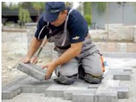
❶ Ułożenie nawierzchni najlepiej zlecić doświadczonym brukarzom, którzy mają specjalistyczne narzędzia – spychacz, wibratory powierzchniowe oraz wiedzę i doświadczenie w pracach tego typu. BRUK-BET
