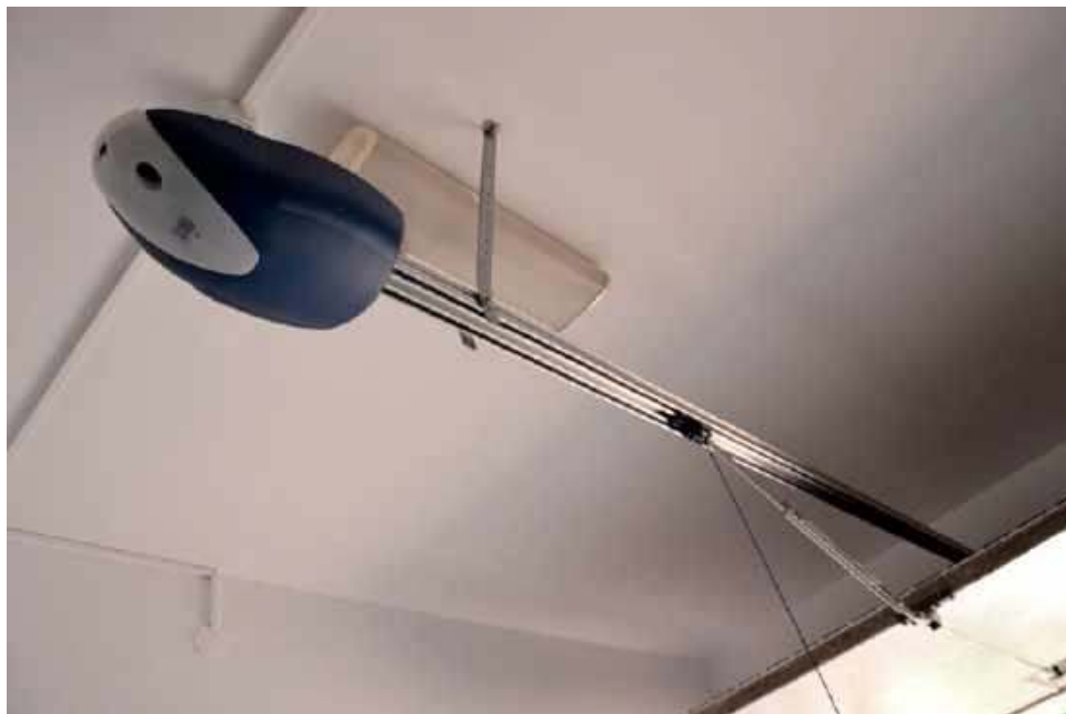
🔌 📶 Siłowniki przeznaczone do skrzydeł otwieranych do góry montuje się pod sufitem. L. JAMPOLSKA, BENINCA
