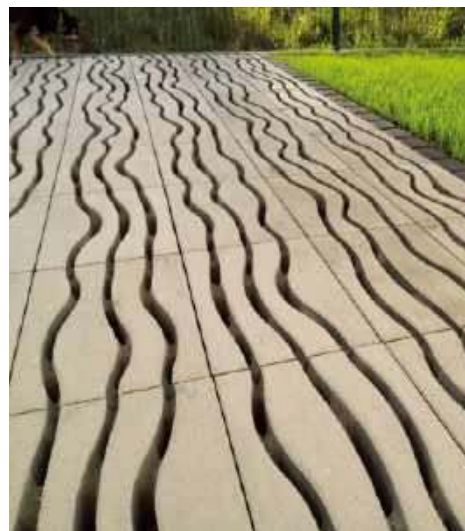
📍 Płyty betonowe z otworami imitującymi nurt strumienia. KAMAL
