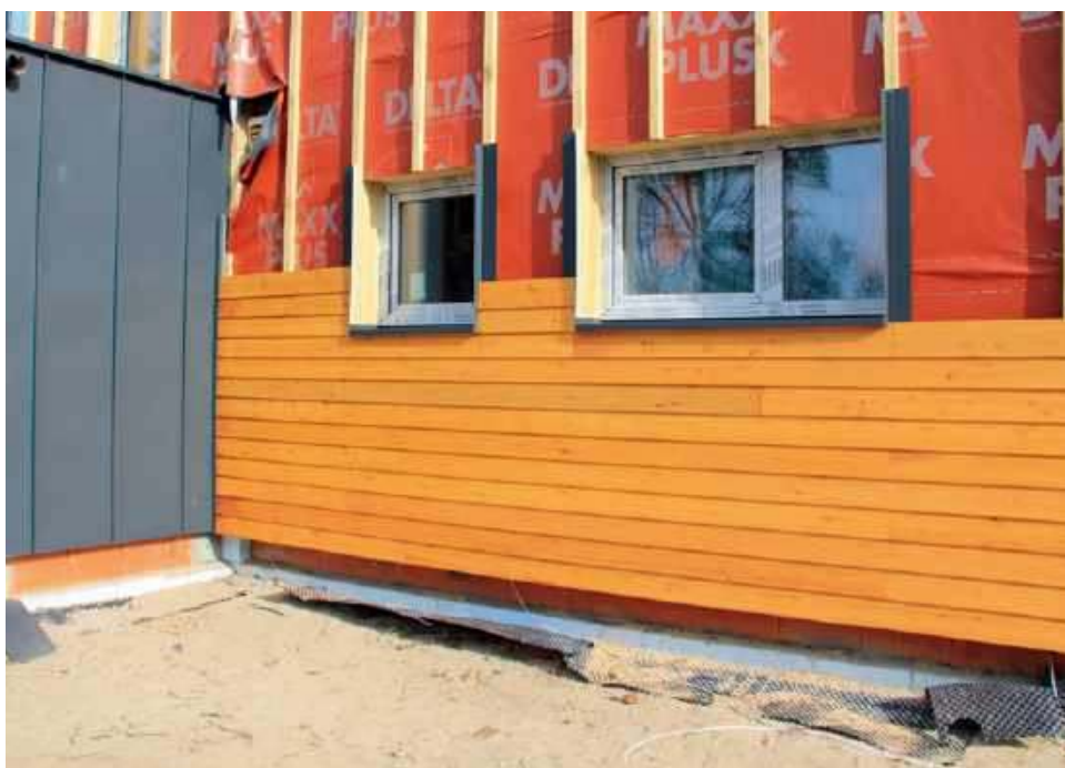
❶ Ściana dwuwarstwowa ma lepsze właściwości dźwiękochłonne, gdy jest ocieplona metodą lekką suchą, w której izolację osłania np. drewniana oblicówka. J. WERNER
