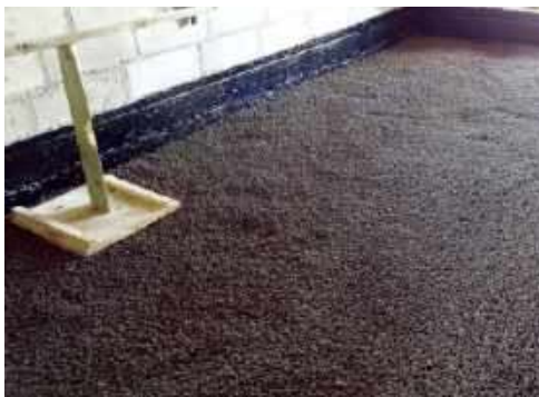
🔧 Granulat z keramzytu stosuje się do ocieplania podłóg na gruncie. SAINT-GOBAIN
