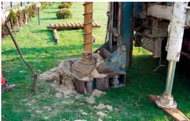
📍 Odwiert pod wymiennik pionowy. NIBE-BIAWAR
