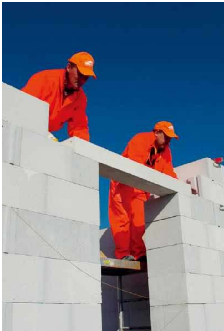
📍 W ścianach jednowarstwowych, żeby uniknąć mostków termicznych, stosuje się elementy systemowe, np. prefabrykowane nadproża. TERMALICA (BRUK-BET)
