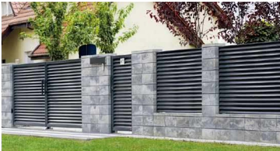
📌 Solidne murowane ogrodzenia powstają dziś na ogół z bloczków betonowych, oferowanych w różnych wariantach wykończenia. JONIEC
