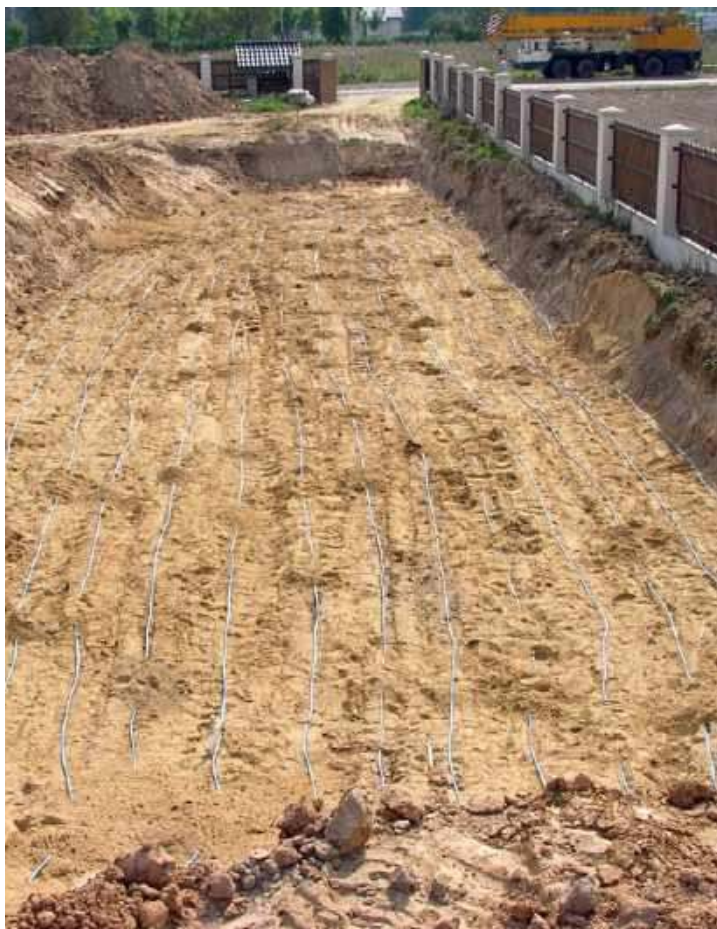
📍 Wykop pod poziomy kolektor gruntowy. CLIMA KOMFORT
