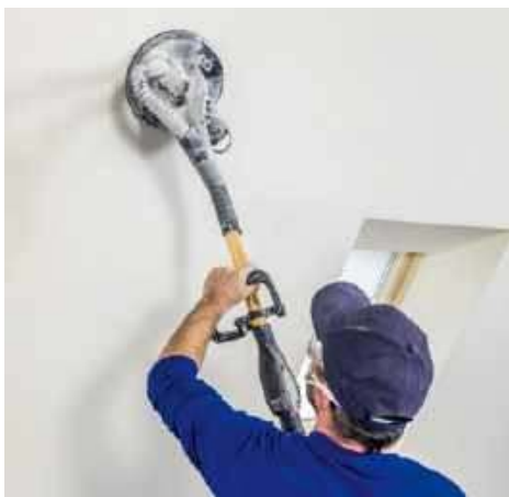
🔗 Gładź wyrównuje się specjalną maszyną na wysięgniku, tzw. żyrafą. KNAUF
