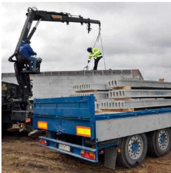
📍 Do układania lżejszych stropów prefabrykowanych wystarczy HDS, czyli samochód ciężarowy z żurawiem. STROPY.PL
