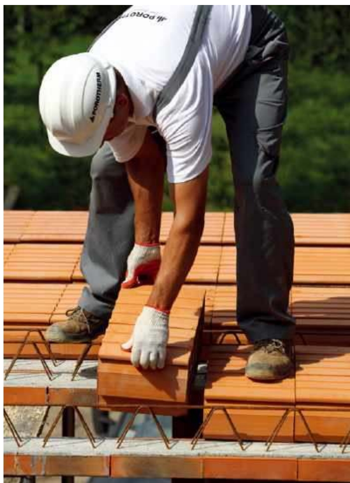
🔧 Strop gęstożebrowy tworzą belki (żebra), między którymi ręcznie układa się pustaki. WIENERBERGER
