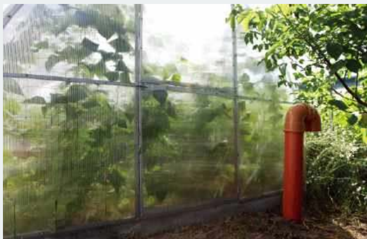
❶ Czerpnia powietrza znajduje się nad przeponowym (rurowym) GWC.
