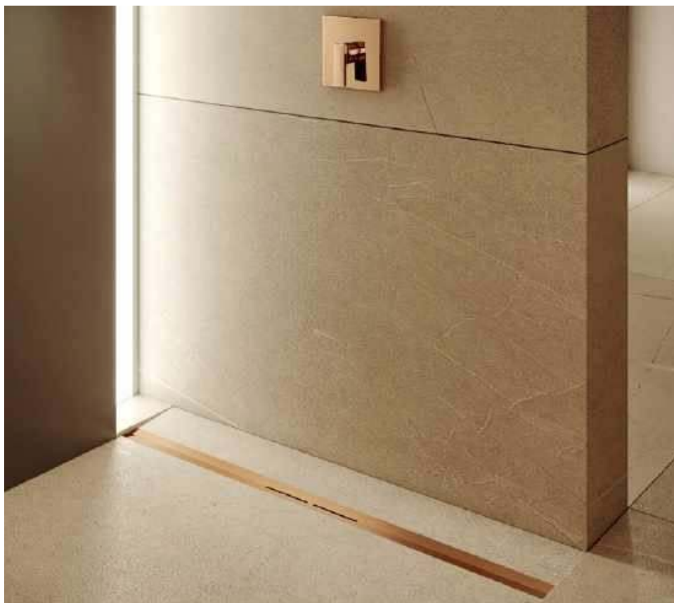
i Natrysk z odwodnieniem liniowym nie ma progów, utrudniających wejście. TEECE
