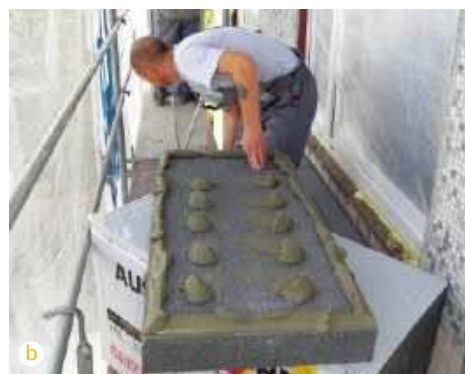
🔔 Naniesienie, za pomocą pacy, zaprawy klejowej na brzegi płyty (a) oraz punktowo w równych odległościach na całą powierzchnię (b). Płyty mają zazwyczaj wymiary 500 × 1000 mm. AUSTROTHERM
