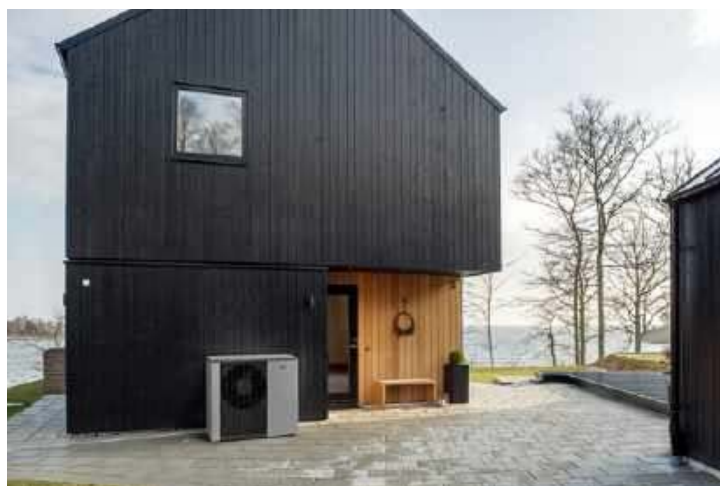
🔊 Powietrzna pompa ciepła typu monoblok. NIBE-BIAWAR
