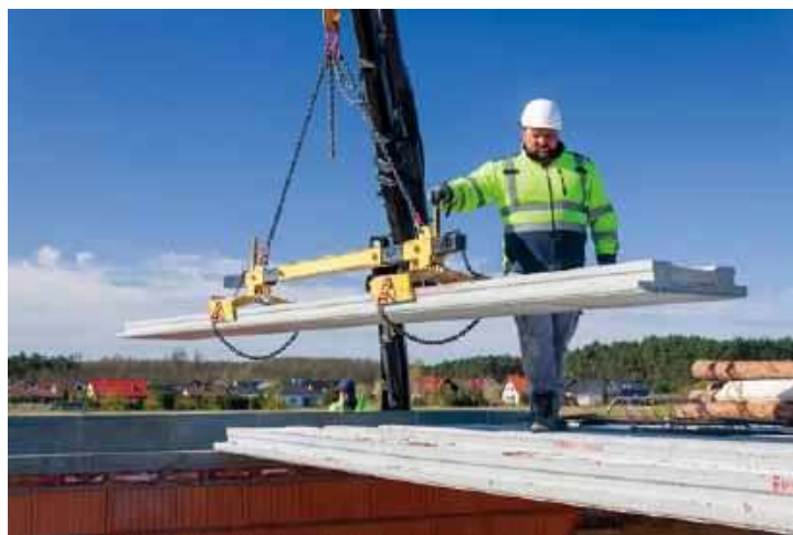
📍 Stropy panelowe układa się z prefabrykatów o szerokości 60 cm. STROPY.PL
