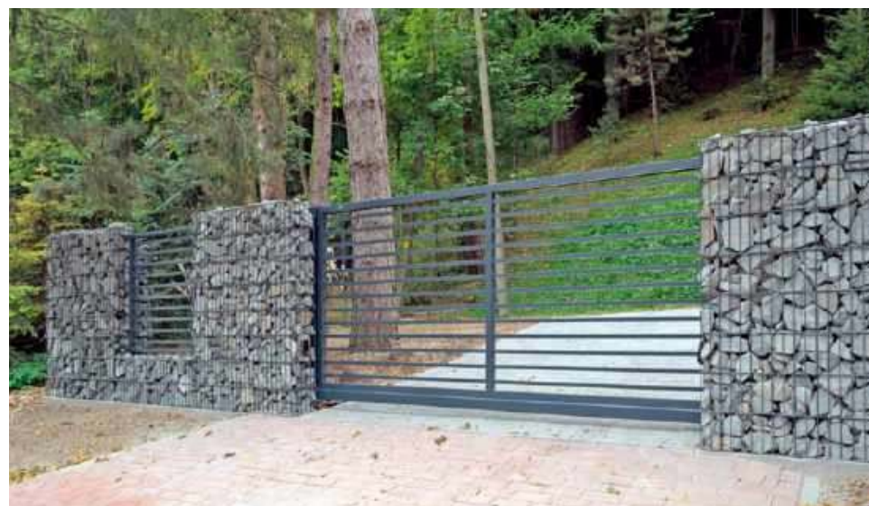
📍 Gabionowe panele, czyli kosze z drutu wypełniane kamieniem i stabilizowane od wewnątrz słupkami betonowymi w podłożu, to ostatnio bardzo modna opcja. PLAST-MET SYSTEMY OGRODZENIOWE
