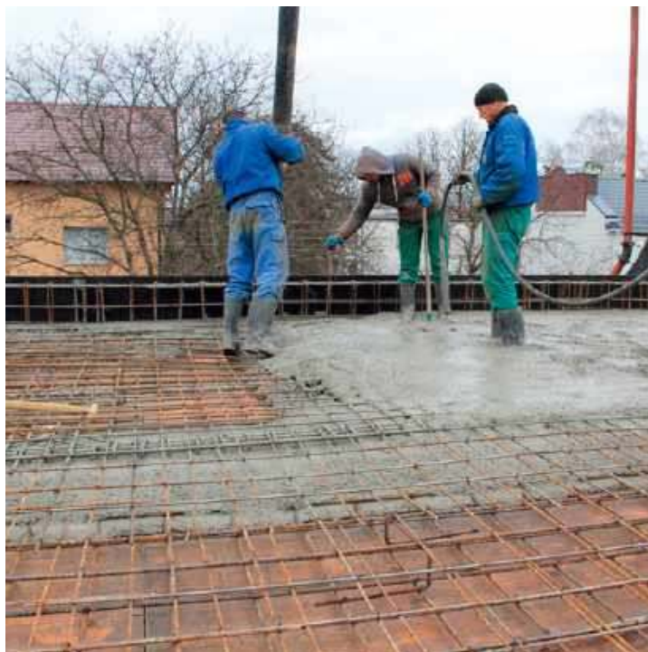
🔧 Budowa stropu monolitycznego jest czaso- i pracochłonna. J. WERNER
