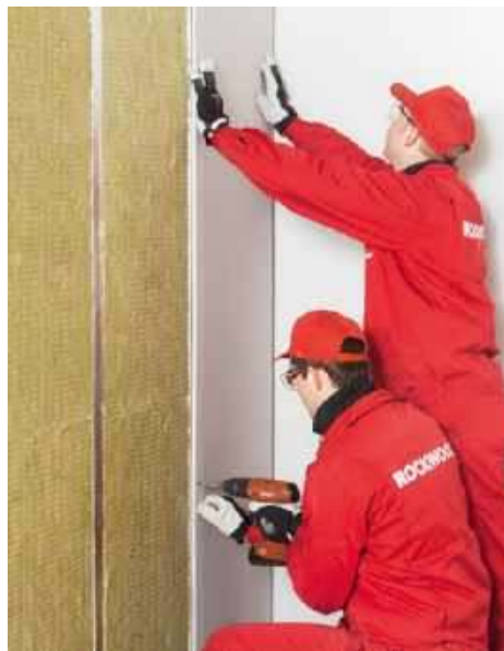
🔴 Lekka ścianka, wypełniona wełną mineralną i obita płytą g-k, izoluje akustycznie równie dobrze, jak masywna przegroda. ROCKWOOL
