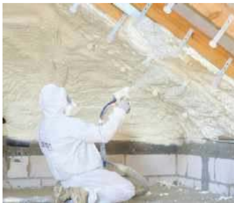
🔧 Poddasze można ocieplić natryskując piankę poliuretanową. PCC PRODEX
