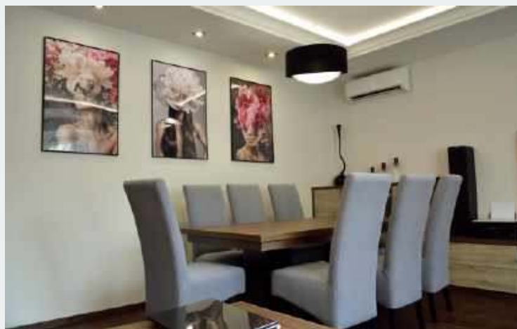
● W salonie klimatyzator zawieszono daleko od okna.
