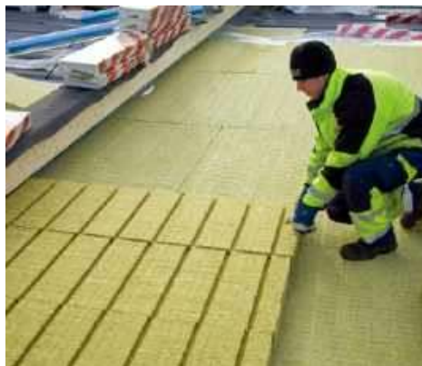
🔧 Termoizolację dachu płaskiego z płyt wełny mineralnej przykrywa się dwiema warstwami papy termozgrzewalnej. PAROC
