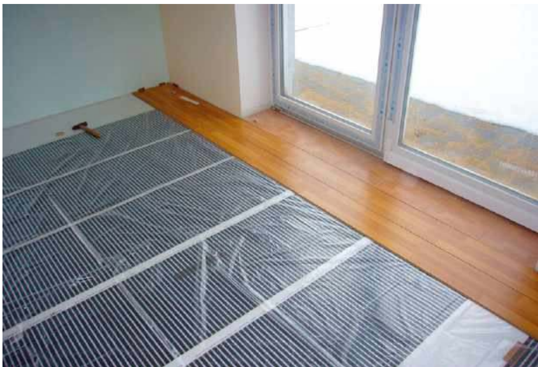
Folia grzewcza o grubości 0,4 mm układana pod panelami. FENIX POLSKA
