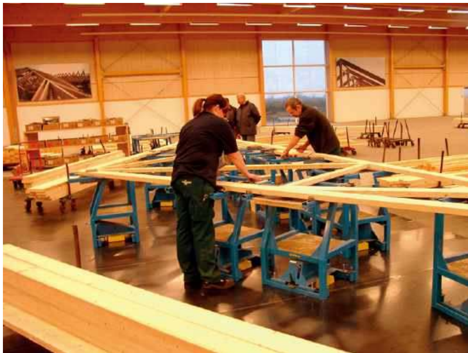
➤ Prefabrykacja to precyzyjna produkcja fabryczna, z użyciem maszyn i narzędzi niedostępnych na placu budowy. MITEK
