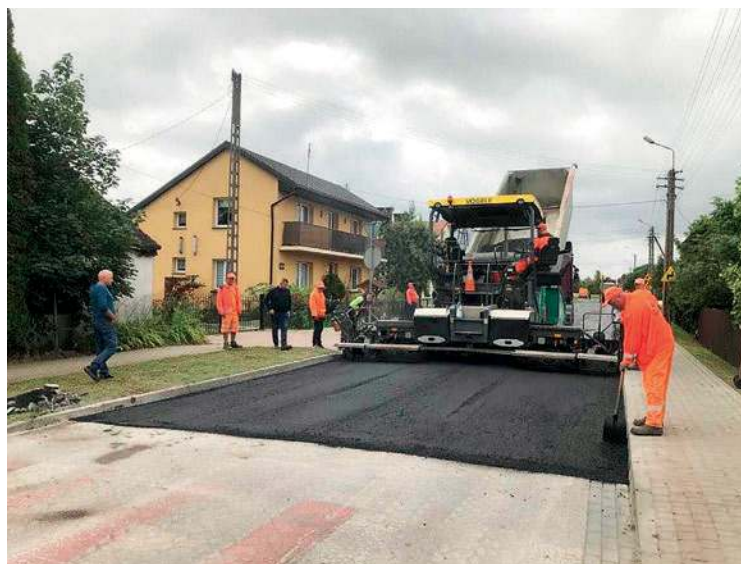
Ruszyły prace związane z położeniem nowej nawierzchni m.in. w Gościejewie (gm. Karniewo).
