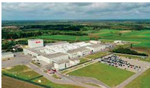
Wyciek został odkryty przez pracowników w godzinach rannych
