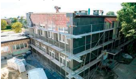
Remont SP nr 5 przy ul. Broniewskiego
