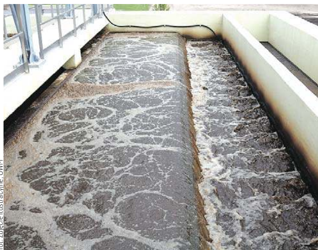
Całkowity koszt wszystkich robót związanych z rozbudową sieci kanalizacji sanitarnej i modernizacją oczyszczalni ścieków w Drulitach wyniósł 985 360 zł
