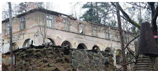
Pozostałości po Uniwersytecie Ludowym w Rudziskach
