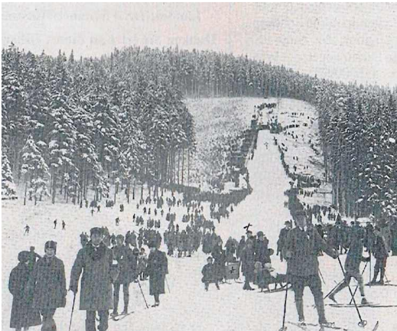
Skocznia przy Owczych Skałach w Szklarskiej Porębie przetrwała do lat 70. XX wieku
