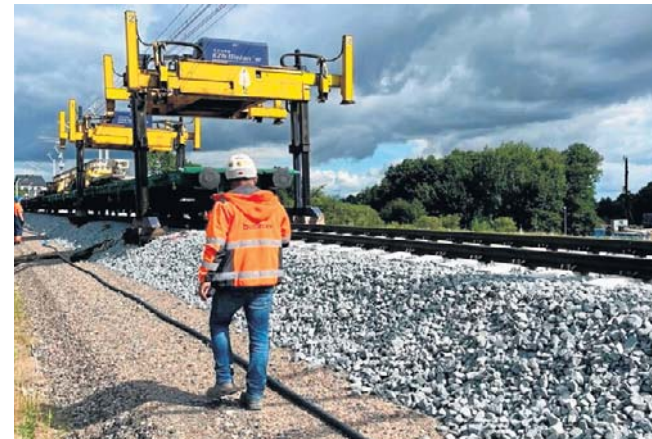
Dostawa rozjazdów jest kolejnym etapem modernizacji linii kolejowej nr 201 na odcinku Kościerzyna - Gdańsk
