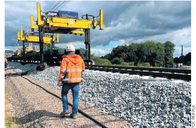
Dostawa rozjazdów jest kolejnym etapem modernizacji linii kolejowej nr 201 na odcinku Kościerzyna - Gdańsk
