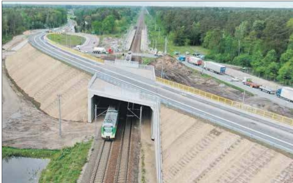
Wiadukt drogowy zastąpi przejazd kolejowo-drogowy w ciągu ulicy Kościuszki, co zwiększy sprawność i bezpieczeństwo w ruchu pociągów, ale przede wszystkim usprawni ruch w mieście. Dodatkowo ruch samochodów ciężarowych zostanie skierowany poza centrum Międzyrzecza
