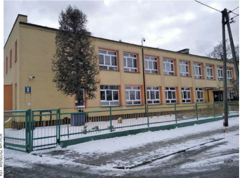
Kuchnia i zaplecze kuchenne w przedszkolu nr 6 w Stalowej Woli przejdzie modernizację
