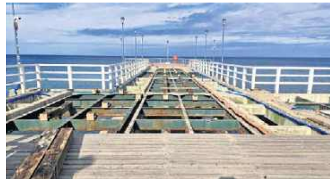
Zanim na molo zamontowane zostaną nowe deski i legary, konserwację przejdzie m. in. jego konstrukcja
