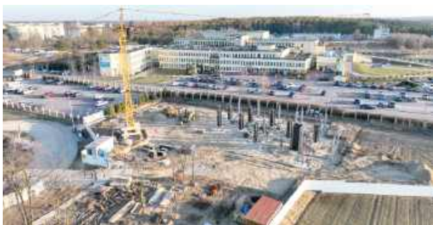
Centrum Zdrowia Psychicznego w budowie. Teraz wykonawca musi nadrobić czas, bo Centrum ma być wybudowane do końca 2026 roku. Na dodatek wprowadzane są zmiany w projekcie
