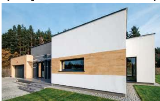
Możemy znacznie ograniczyć prawdopodobieństwo pojawienia się na ścianach grzybów-pleśni, ocieplając odpowiednio dom i wykorzystując do jego wykończenia materiały budowlane, które, oprócz szeregu innych funkcji, będą także wspierały regulację mikroklimatu
